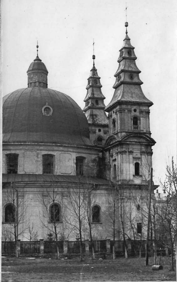
← 2. Фрагмент северо-восточного фасада.
