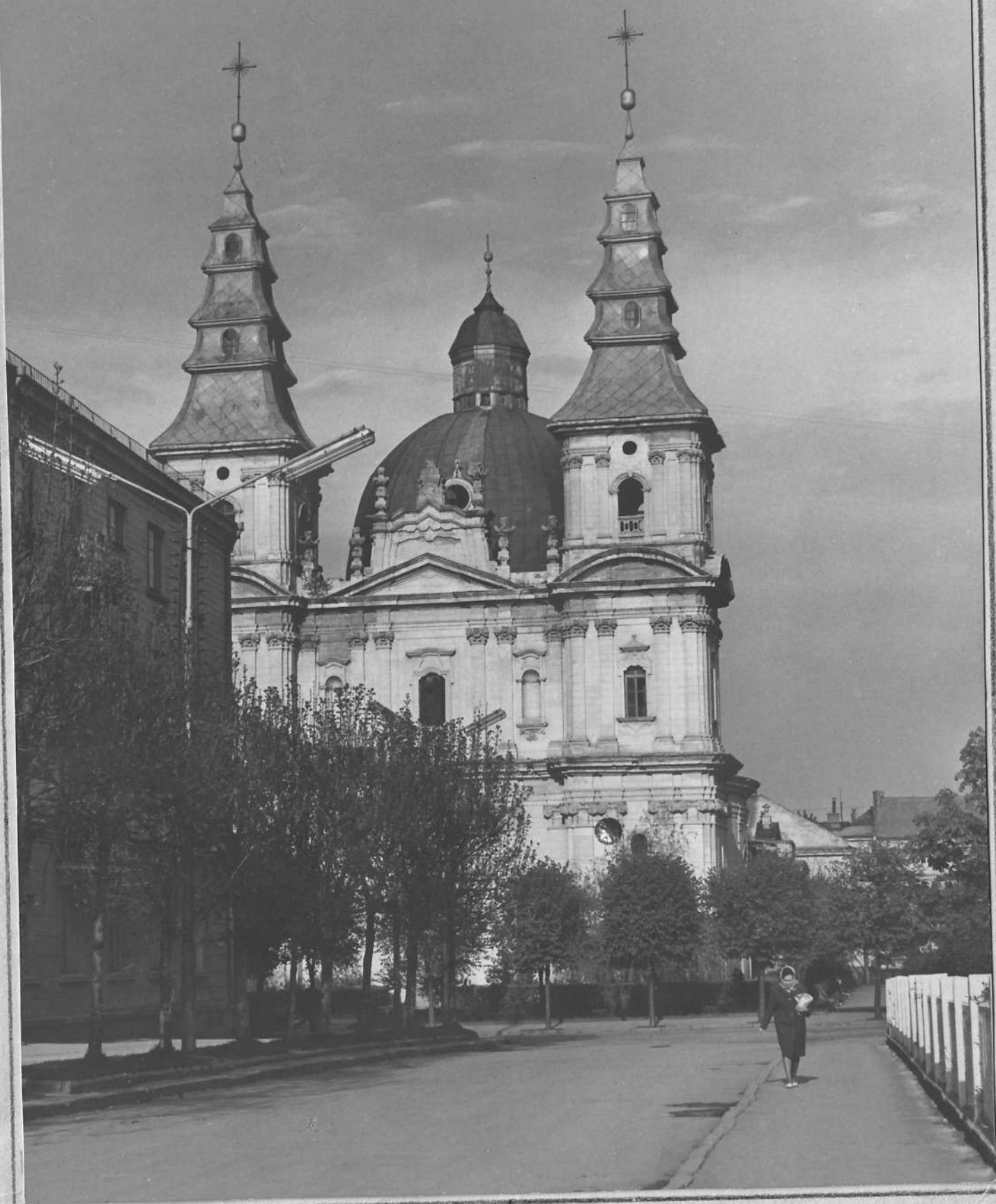
1. Костел Доминиканцев, 1749г. в г. Тернополье. Западный фасад.
