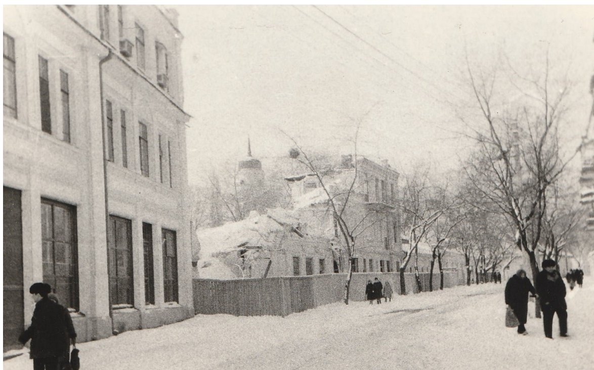
Вулиця Притисько-Микільська. Будівля на вул. Фролівська, 4 (ліворуч) та Будинок шевського цеху у процесі знищення (праворуч). Фото. 1985 р.
