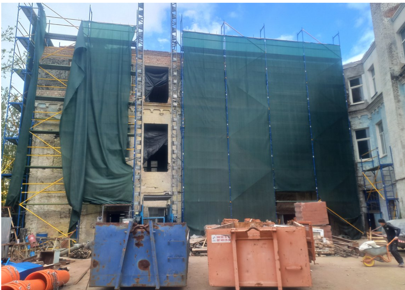
Фото загроз (дії негативних чинників). Відсутність покрівлі даху та заповнення віконних прорізів на дворовому фасаді. Фрагменти
