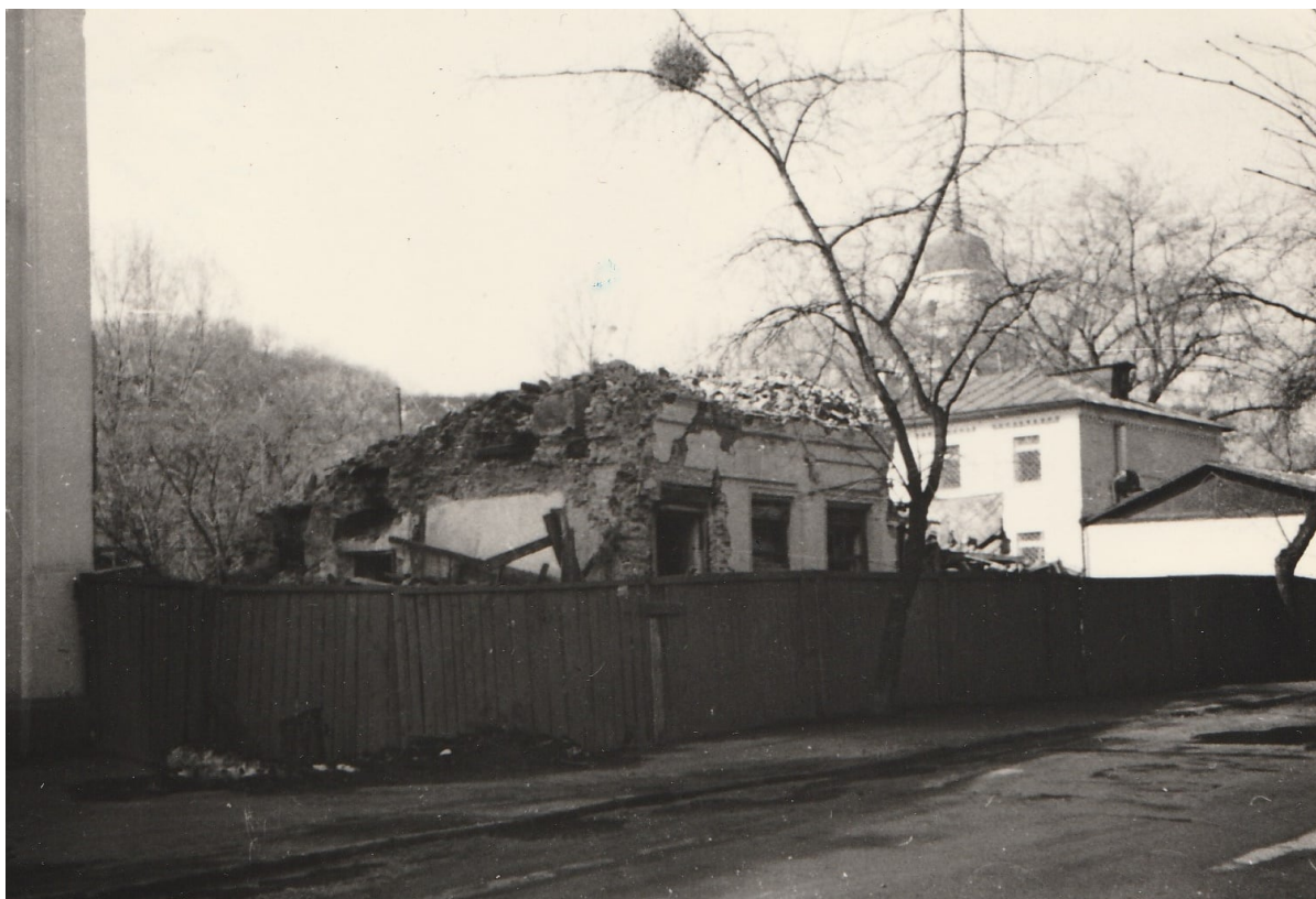
Завершення знесення будинку колишнього шевського цеху. Фото. 1985 р.
