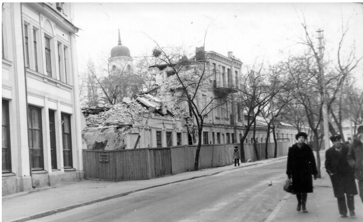
Вулиця Притисько-Микільська. Будівля на вул. Фролівська, 4 (ліворуч) та Будинок шевського цеху у процесі знищення (праворуч). Фото. 1984 р.
