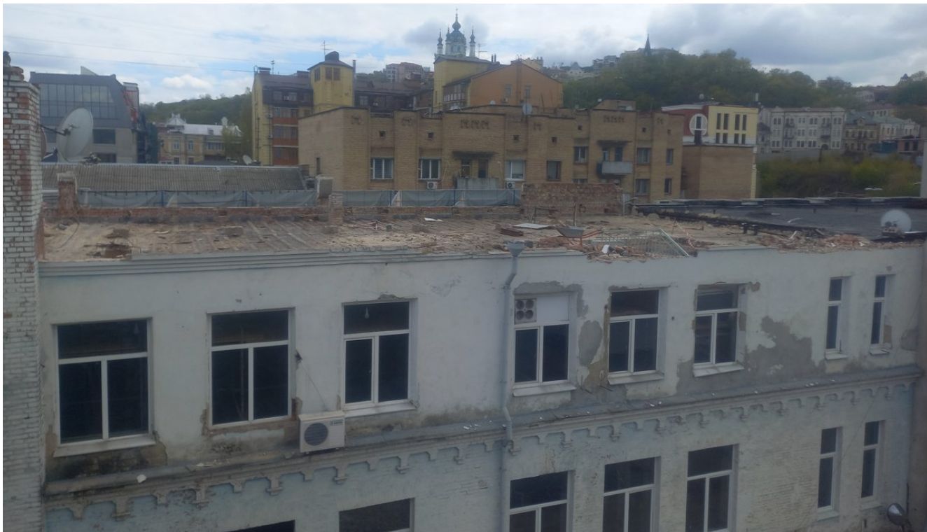
Фото загроз (дії негативних чинників). Відсутність покрівлі даху та заповнення віконних прорізів на дворовому фасаді. Фрагменти
