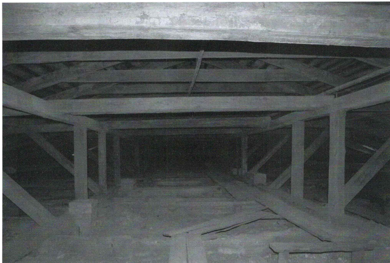
Вул. Володимирська, 60. Університет. Дерев'яні крокви даху.
