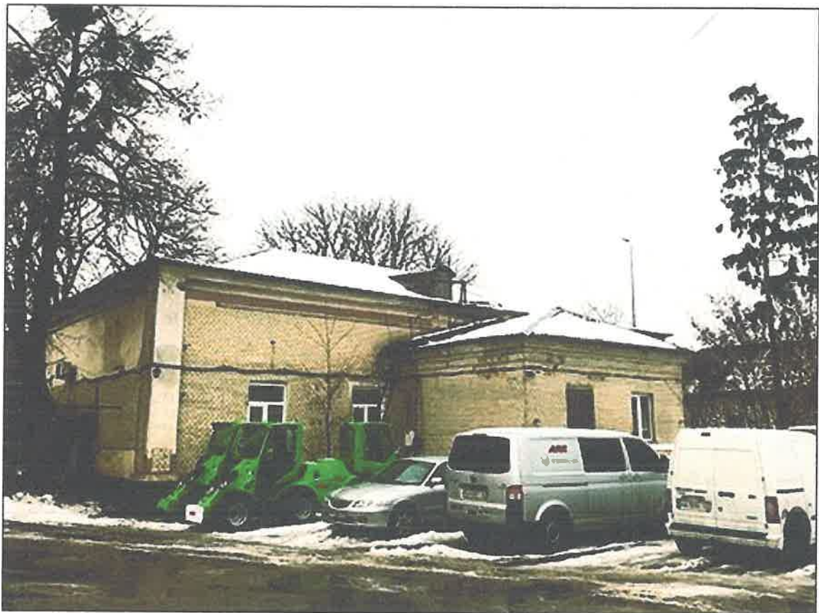
Бічний фасад. Фрагмент
